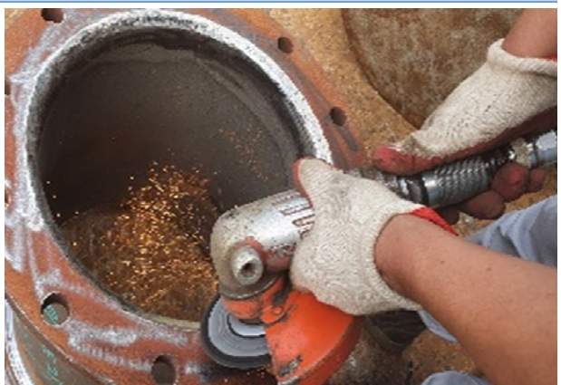
휴대용 연삭기를 이용한 사상 작업
