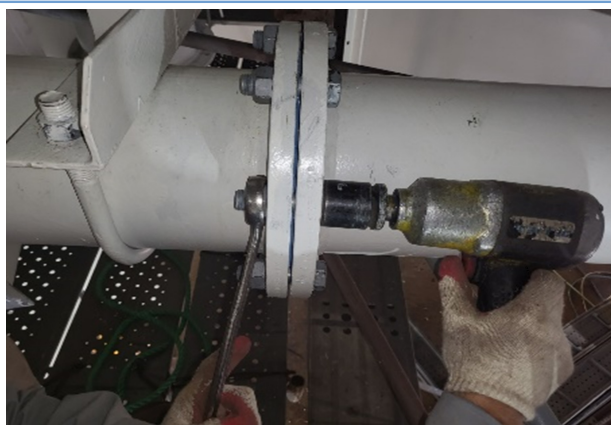
전동렌치를 이용한 배관 연결 작업
