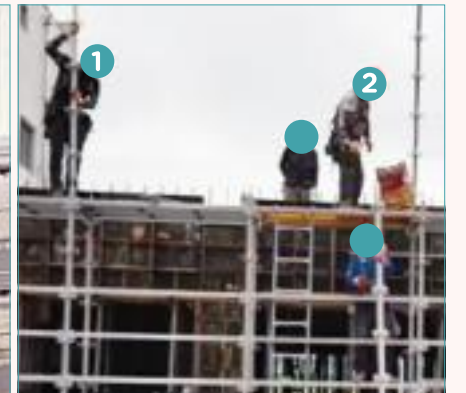
시스템비계 설치 작업자(①~②) 추락 위험
