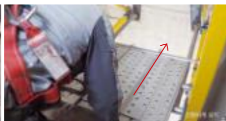
▲ 신형비계(외부에서 조립하여 밀어 넣어 설치)
