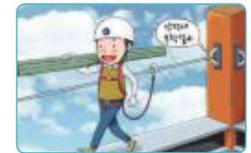
6 안전대 착용 및 안전대 부착설비에 안전고리 체결
