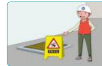
2 개구부 덮개 및 경고표지 설치
