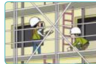
1 추락위험장소에 안전난간 설치
